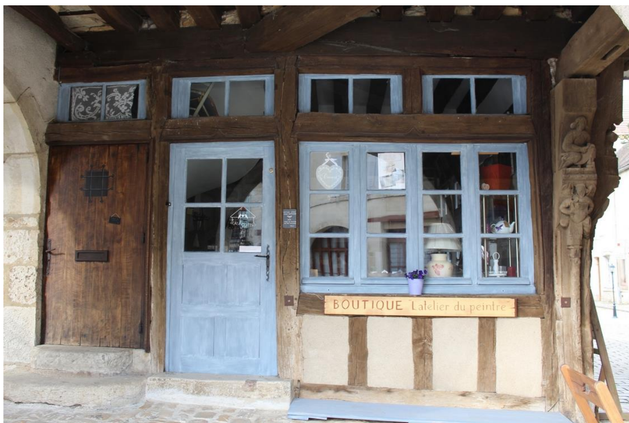
Baies d'ouvrier d'une maison à boutique de Noyers (Yonne) (A. Lacaille, Inrap)
